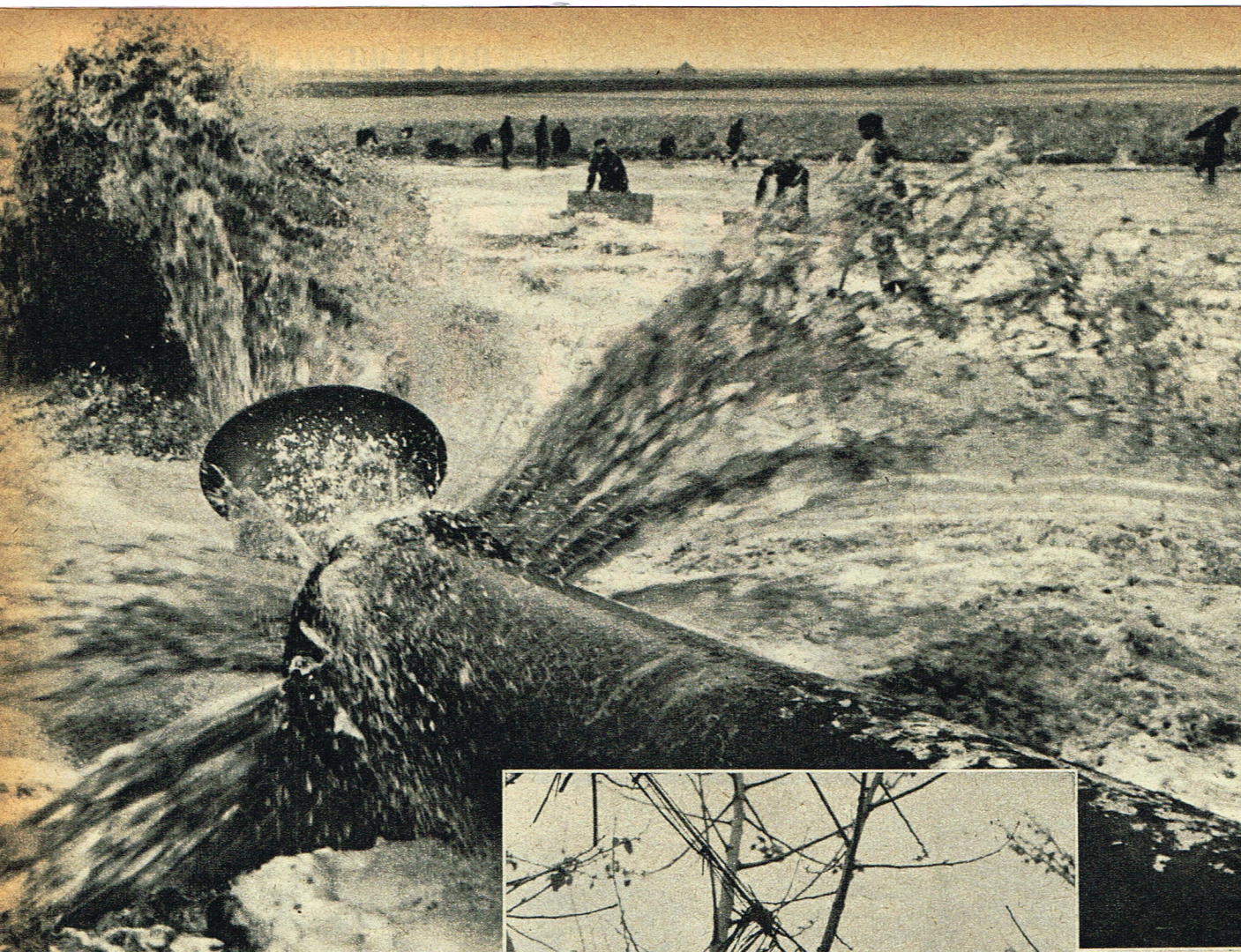
Fel spuit en borrelt de modderstroom op „het stort" uit de persleiding. Als volleurde dijkwerkers manoeuvreren kruideniers, slagers, landarbeiders en bouwers met schotten en spaden om het zand voor de nieuwe buitendijk te laten bezinken.
